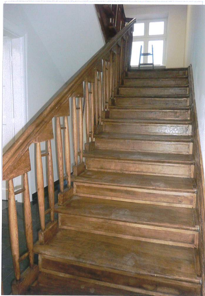
Fot. 10. Schody głównej klatki schodowej, 2019.
