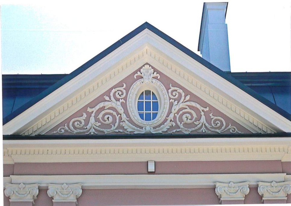
Fot. 5. Elewacja frontowa (północna) – tympanon, 2019.
